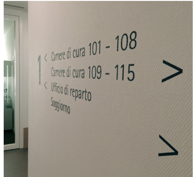
Segnaletica direttamente al muro realizzata con sciabloni e pittura.
